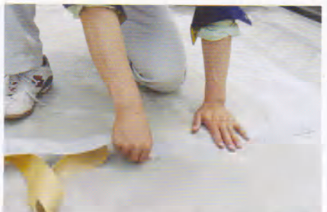
シンダーコンクリートの目地部分の補強を行います。伸び性が高く、補強メッシュと一体となったブチルゴム系特殊防水テープを貼り付けます。
