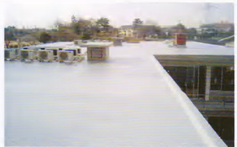
露出工法により防水施工を行いました。
