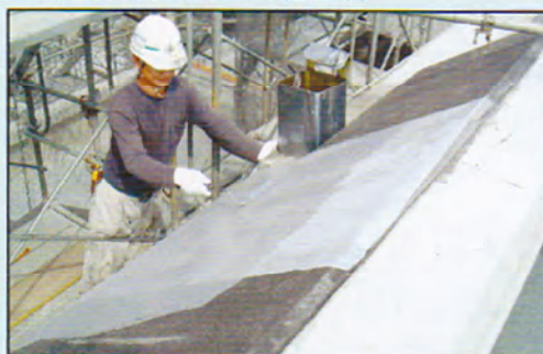
C工法(ウエルズパーク久が原新築工事)【東京都】
