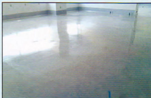
C工法(ロッテ浦和工場増築工事)【埼玉県】
