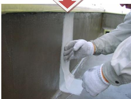
塗布したタケシール AQ 防水 TypeS を塗布後、乾燥しないうちに、カットしておいた補強クロスを貼り付けます。
