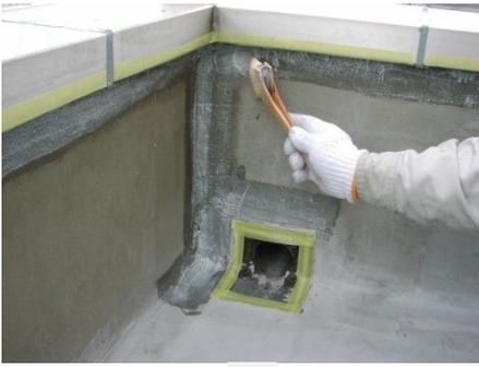
タケシールAE211プライマーを2時間以内で塗りきれぬ量を作成し、入隅、角の部分からハケで、下地面に十分に浸透する様に塗ってください。
