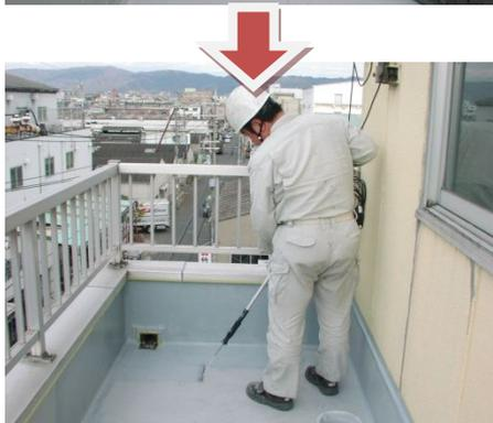
入り隅部分の塗装後、入口より遠い所から、立ち上がり部、床面の平面部の順で塗布してください。
