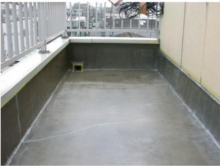
2回目も1回目と同様に**タケシール AE211 プライマー**を1㎡あたり0.15kg塗布します。1回目と合計して0.3kg(300g)/㎡塗布することになります。
