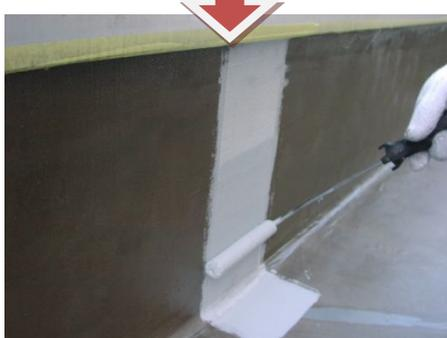
補強クロスを貼り付け後、直ちに、タケシール AQ 防水 TypeS を塗布し、補強クロスを挟み込みます。
