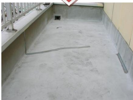
塗布した**タケシール速乾ウレタンシーラント**が乾かない間に、ゴムヘラ等でクラック部分にすり込む様にならし、平滑に仕上げてください。
