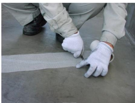
予め補強クロスを、クラック部分のコーキング補修を行った箇所の長さに合わせて少し大きめにカットします。
