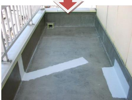
上記のような手順で防水材が乾燥するまでに、この作業が完了する長さを決めて、順番に施工してください。
