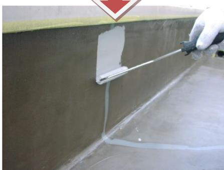
タケシール AQ 防水 typeS を短毛のローラー刷毛などで薄めに塗布します。
