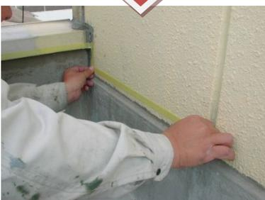
写真はマスキング用紙テープを使用していますが、下地が荒い場合はテープ用プライマーと、養生用布テープを併用して養生してください。
